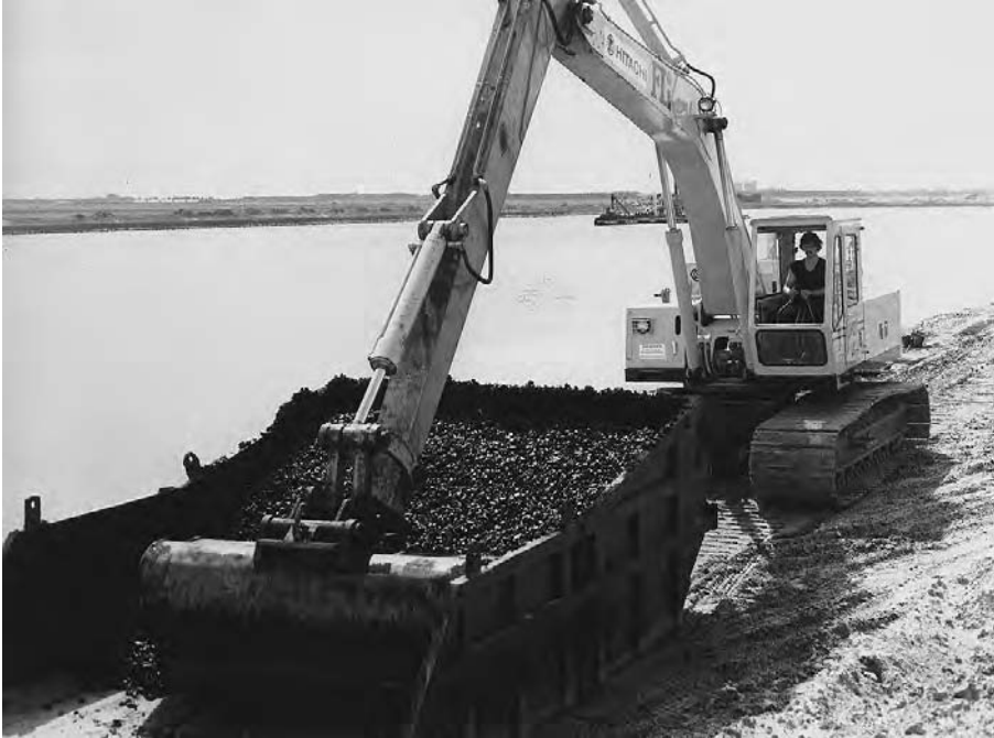
Abb. G 52: Container zur Zwischenlagerung von Mastixgestein an der Einbaustelle (BITUMARIN, 1990)
