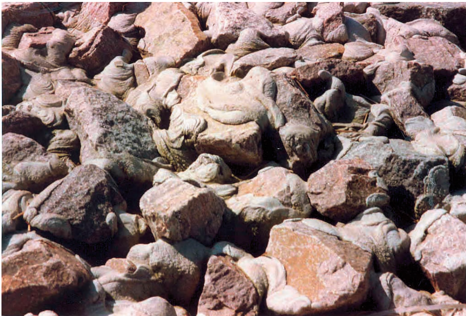
Abb. C 1: Verklammertes Deckwerk (Colcrete-Verfahren)
