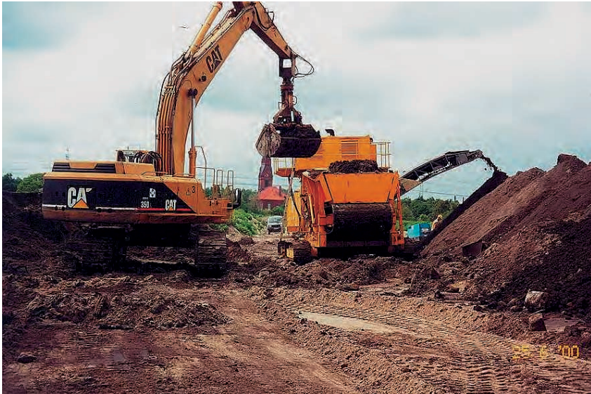
Abb. G 48g: Bodenverbesserung durch Aufbereitungsgeräte
