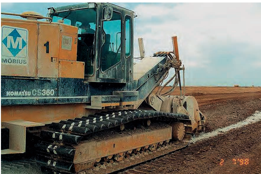
Abb. G 48h: Verbesserungsmaßnahmen durch Fräsen
