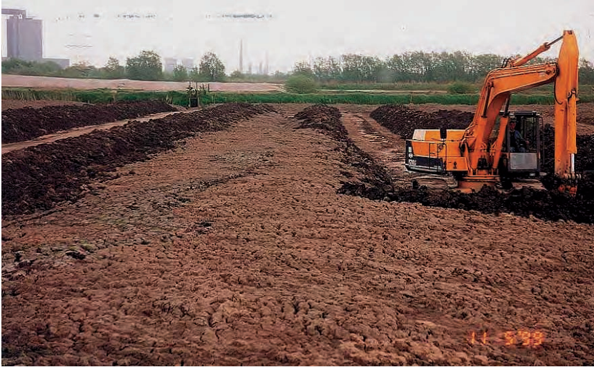
Abb. G 48d: Herstellen von flachen Mieten in einer Deponiefläche
