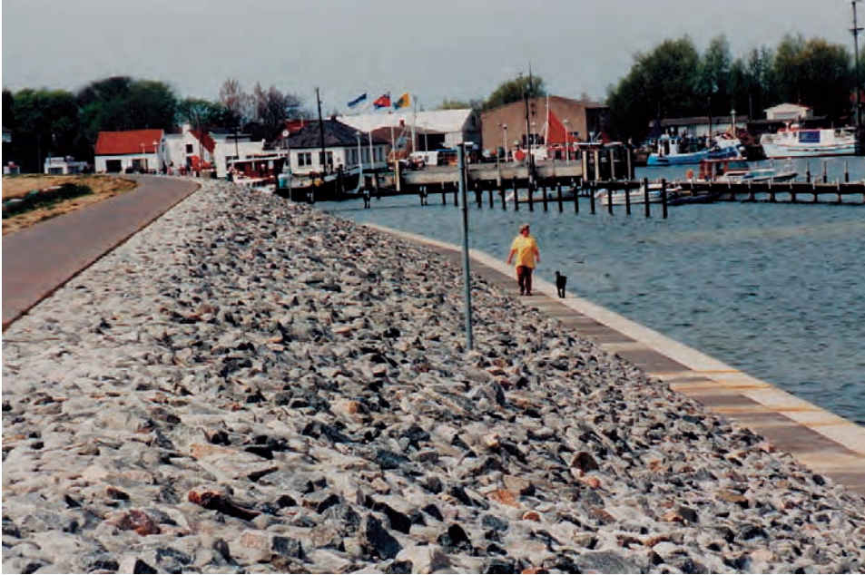
Abb. G 58: Verklammertes Deckwerk zwischen Spundwand und Deichkrone
