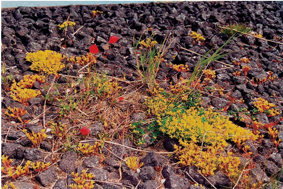
Abb. G 51b: Deichverstärkung Tümlauer Koog 1994/95 (Westabschnitt), Stat. 2+660 bis Stat. 2+860: Deckwerk aus 20 cm Mastixschotter auf der Außenböschung bis zur Dammkrone – wasserdurchlässig und begrünt
