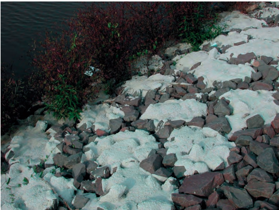
Abb. C 2: Verblockung: Deckwerk mit vergussarmen Zonen (Verblockungssystem Möbius)
