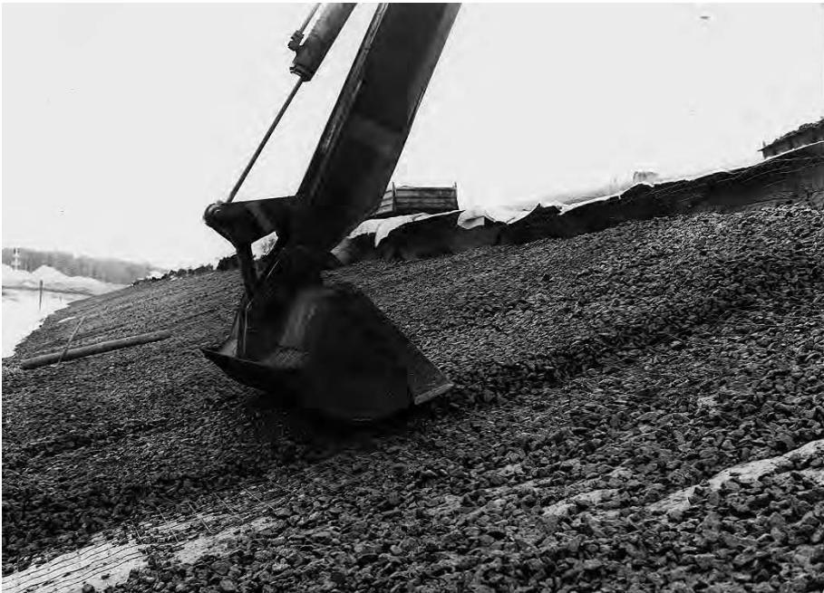
Abb. G 53: Verlegen von Mastixgestein mit dem Hydraulikbagger, leichtes Andrücken mit der leeren Schaufel
